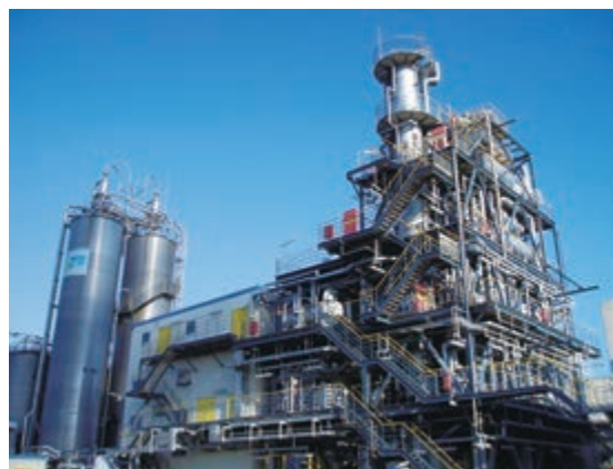
パッケージングマテリアル製造設備（日本）
