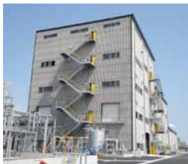
鹿島工場PPS樹脂製造プラント(増設)
