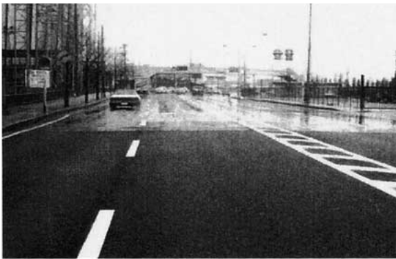
Fig.1 排水性舗装
